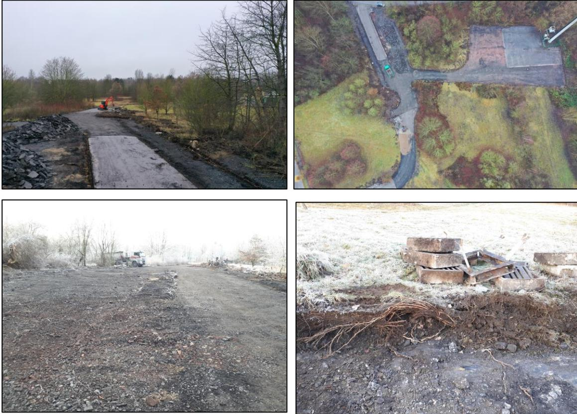
Hinweis: Im Zuge der Entsiegelungsarbeiten dieser Teilflächen wurden weitere kleinere, betonierte Areale unter einer geringmächtigen Bodenaufschüttung entdeckt, die in Q1/2022 entnommen werden.
