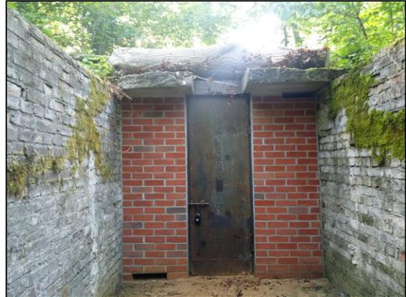
Links: Großaufnahme der Verladerampe mit freigestelltem Gemäuer, Absturzsicherung und entsiegelter sowie anschließend mit Sand abgedecktem Eingang.
